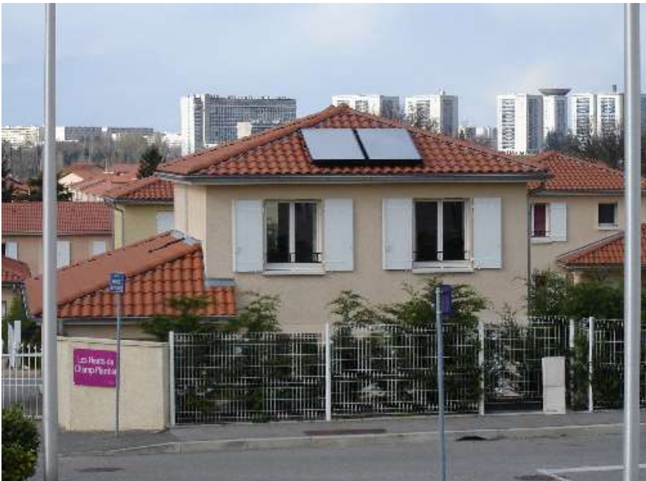
Panneaux solaires en toiture alimentant un chauffe-eau solaire, Feyzin - Champ Plantier, imp. Vilnius - 2008
